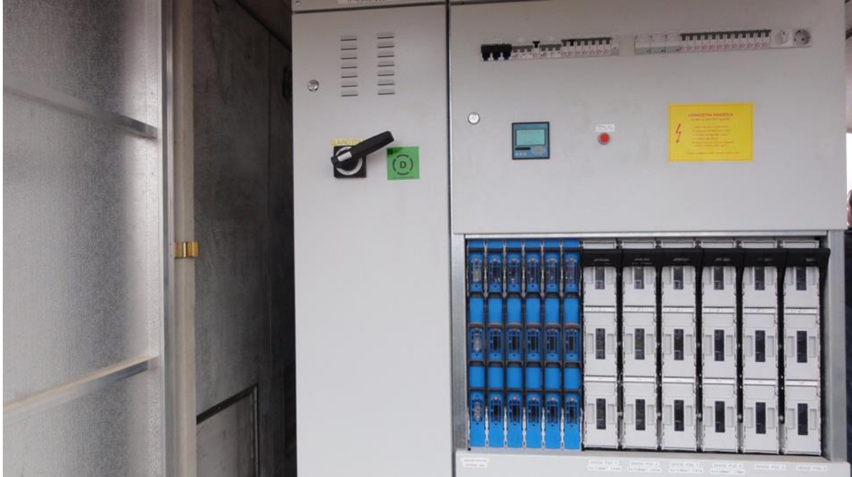
Slika 1: Vgrajeni merilnik v TP
